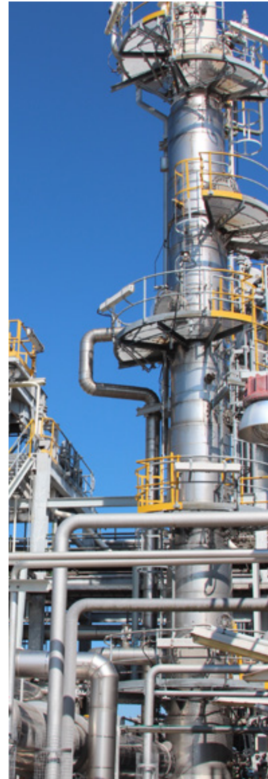
Nhà máy xử lý khí Nam Côn Sơn
